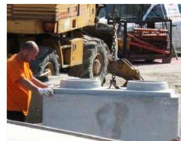
VOCE DI CAPITOLATO : fornitura di blocco modulare MB in cls vibrocompresso con alti dosaggi di cemento a resistenza caratteristica minima Rck 400 ed aventi un peso specifico non inferiore a 2,4 kg/dem ; forma tipica a parallelepipedo delle dimensioni di 1600x800 H=800mm con due fori sull'asse longitudinale ; incastro maschio femmina; peso kg. 2000 ; gancio centrale per la movimentazione
