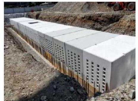
**COME FUNZIONA** - Il sistema "SIS" può operare come bacino di ritenzione o di detenzione. All'interno degli elementi viene accumulata l'acqua meteorica che nella zona interessata potrebbe provocare ristagni o allagamenti. Questo volume di acqua sarà poi smaltito mediante:
